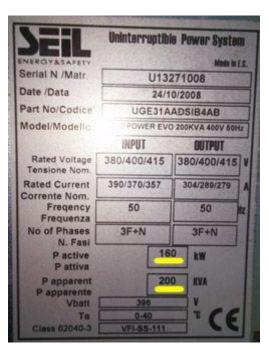
Мощность не всех приборов указана в Вт, например: Мощность трансформаторов указывается в ВА: Мощность конденсаторов указывается в Варах: Примеры других нагрузок - см. приложения ниже.
